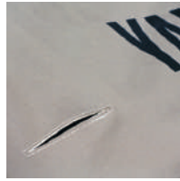
Accès anneaux d'amarrage
